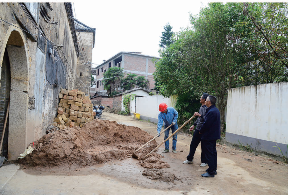
钟彦鹏在围屋修缮现场
